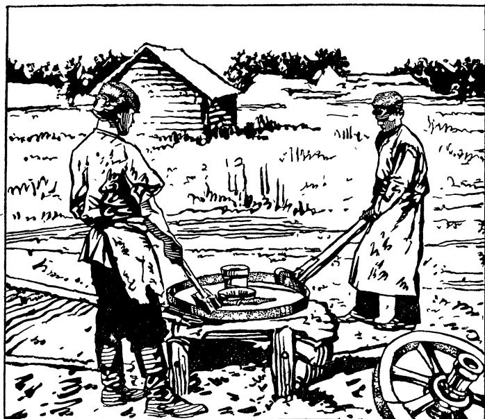
Рис. 1. Обтягивание колеса шиной.
